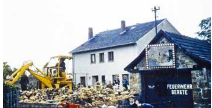
Beginn der Abrissarbeiten an der alten Grenzmauer, August 1963
