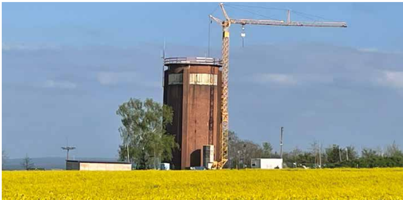
Wasserturm Ginnick im Umbau, 2022
