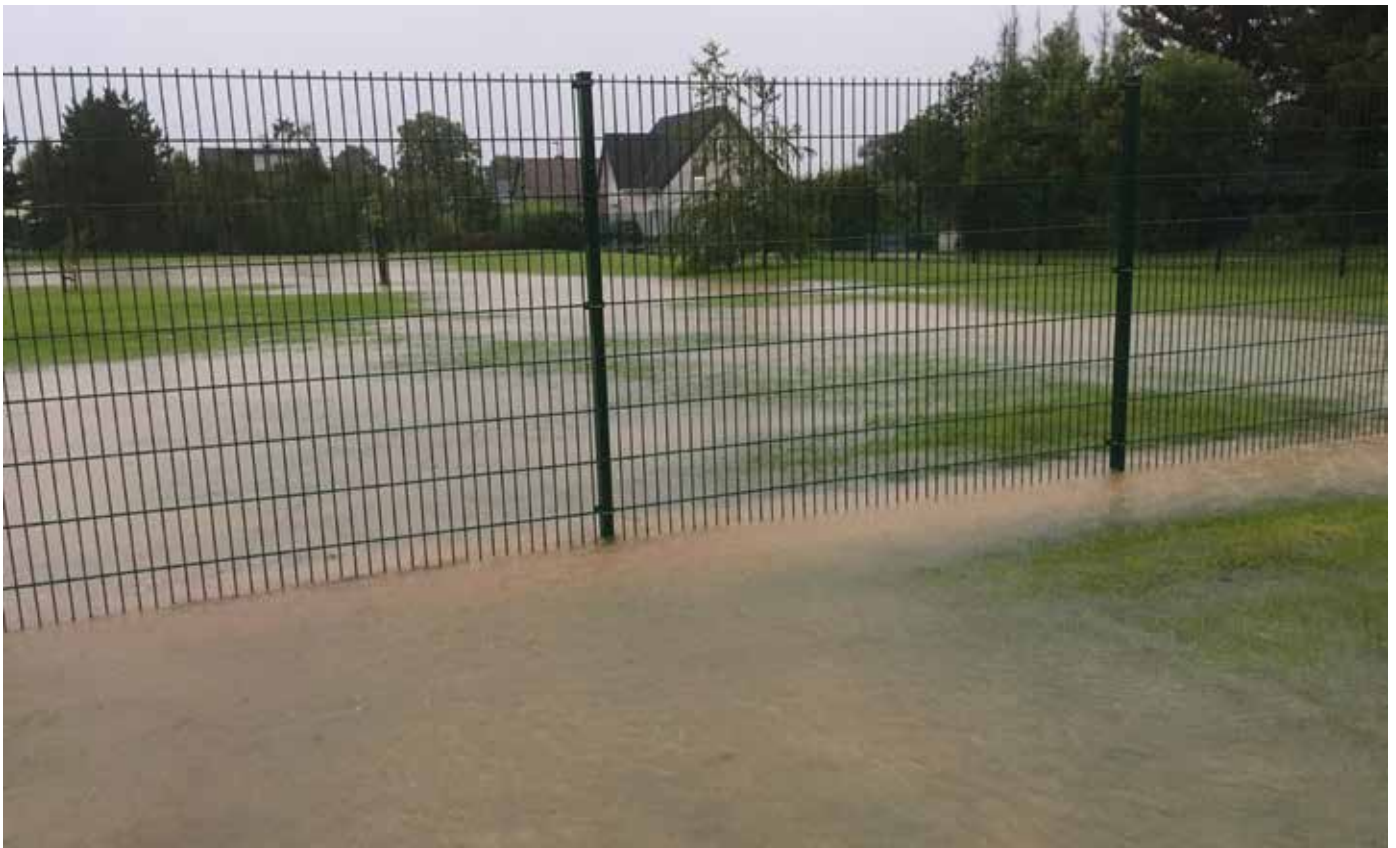
Ginnicker Regenrückhaltebecken. Eine unterirdische Rollkiesspeichermasse nimmt das Wasser auf und leitet es unterirdisch in den Schildgenbach ab.
