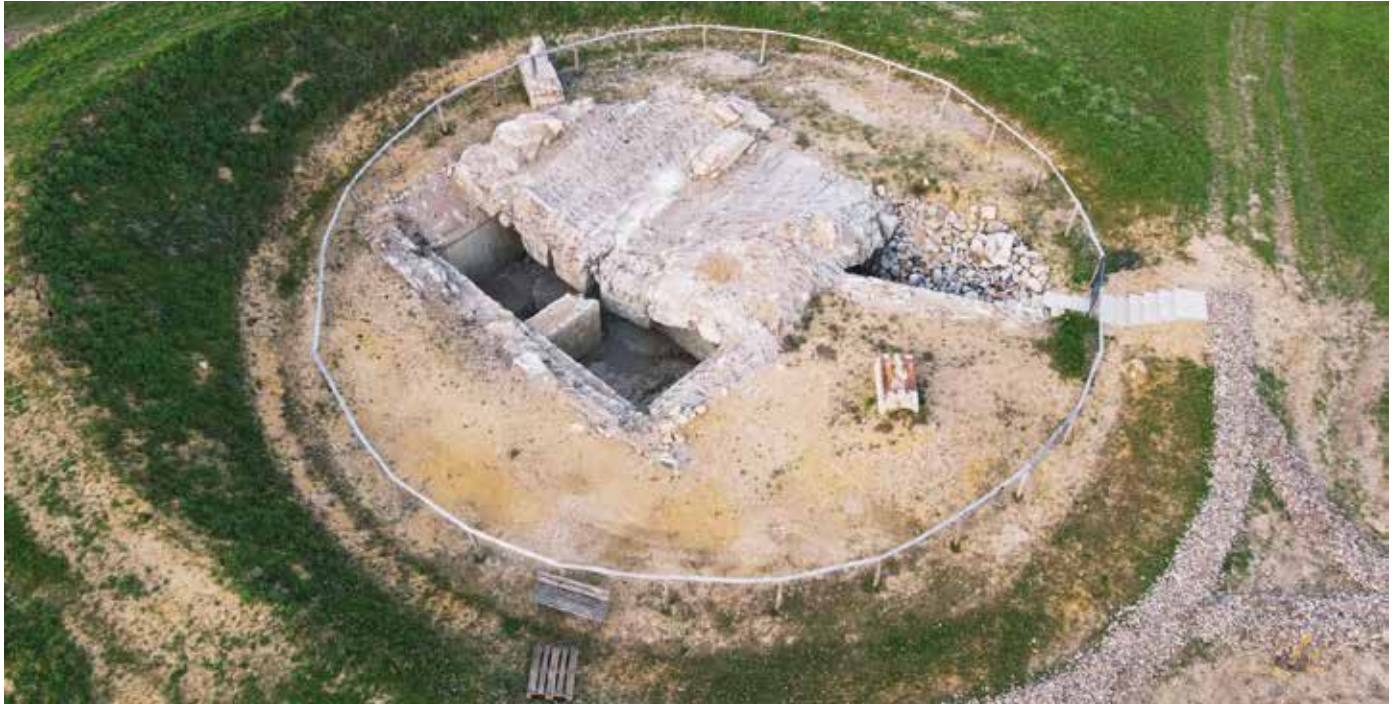
Bunkerüberrest nach versuchter Sprengung – heute Quartier für Fledermäuse
